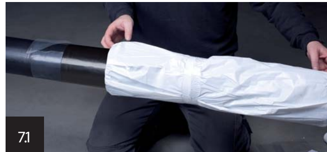
A zsugorkarmantyú beállítása
