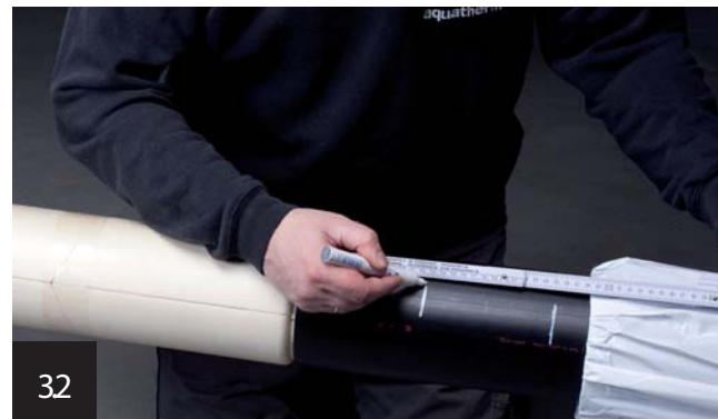
A zsugorkarmantyú helyének kijelölése
