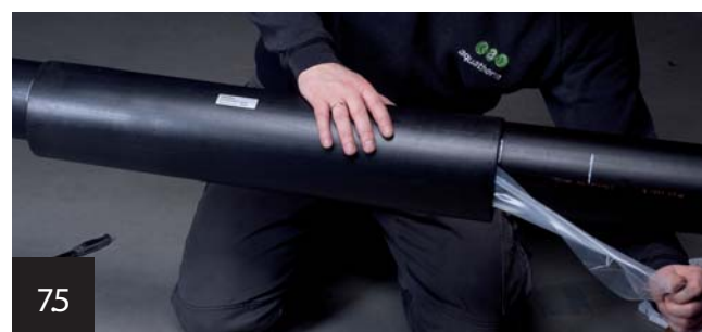
Az olvadószalag védőfóliájának eltávolítása
