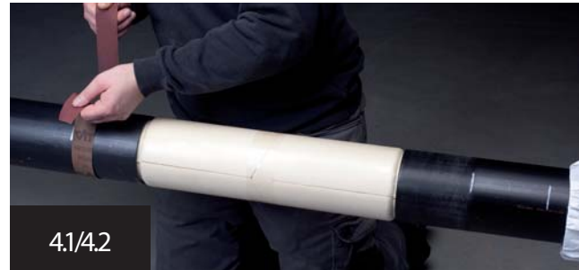
A tömítő felület előkészítése
