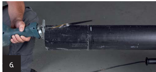
6 A köpenycsövet műanyag vágásra alkalmas fűrészlappal ellátott róka farkú fűrészszel, vagy orrfűrészszel a PUR szigetelésig felvágni
