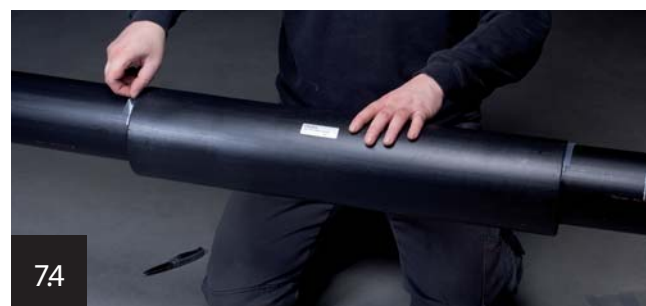
Az olvadószalag védőfóliájának eltávolítása
