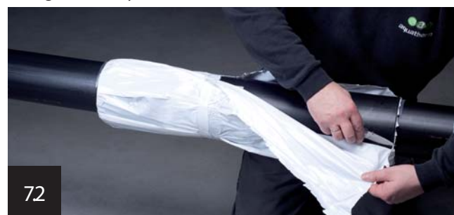
A zsugorkarmantyú beállítása
