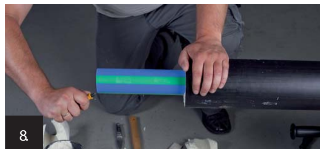
8 A szigetetlen hosszát megtisztítani és a csővégeket kívülről és belülről sorjatalatítani
