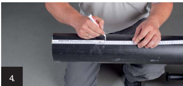
4 A szigetelés levágási hosszát, 22,5 cm-t a köpenycsőre feljelölni
