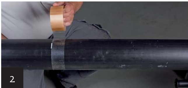
2 A vágási vonalat egy ragasztószalaggal a cső kerületén megjelölni
