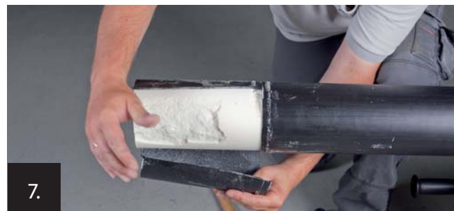
7 A köpenycsövet leválasztani, és utána a PUR szigetelést az egész megmunkálendő hosszban eltávolítani
