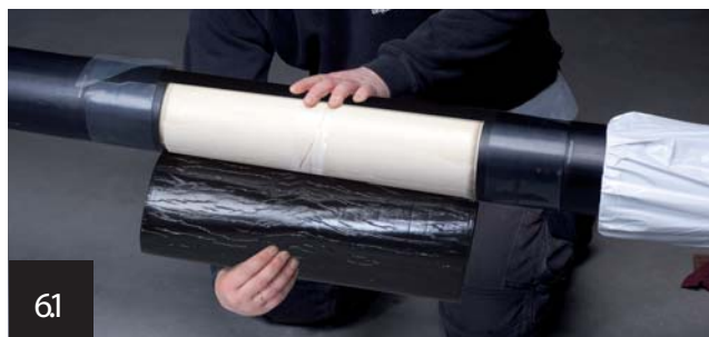
A zsugorfólia szerelése
