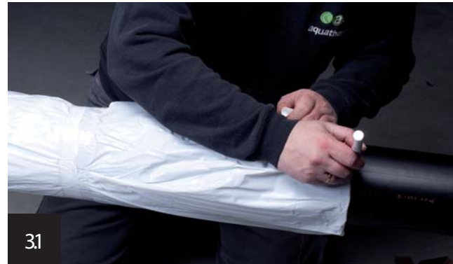
A zsugorkarmantyú helyének kijelölése
