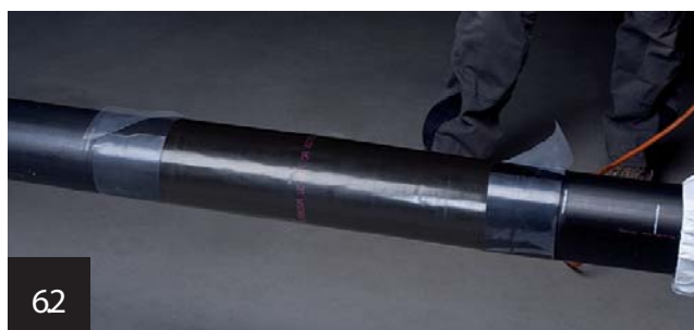
A zsugorfólia szerelése
