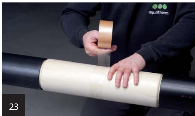
A PUR-szigetelőhéj szerelése
