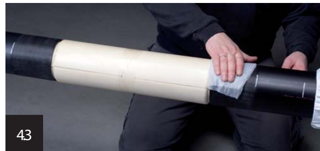
A tömítő felület előkészítése
