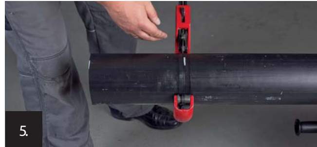
5 A köpenycsövet csővágóval a PUR szigetelésig bevágni
