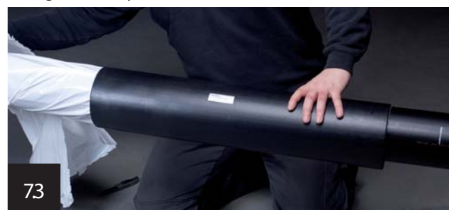
A zsugorkarmantyú védőfóliájának eltávolítása
