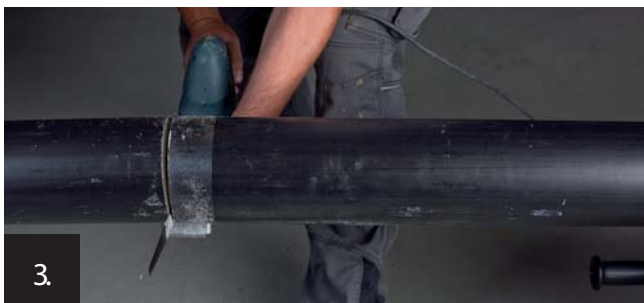
3 A csövet műanyag vágásra alkalmas fűrészlappal ellátott róka farkú fűrészszel, vagy orrfűrészszel a vágási vonal mellett levágni
